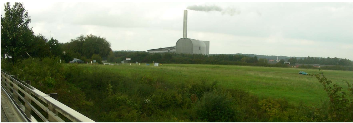
Lokalplanområdet set fra broen over omfartsvejen.
